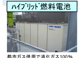
都市ガス併用で消化ガス100%利用可能で発電効率は40%以上
