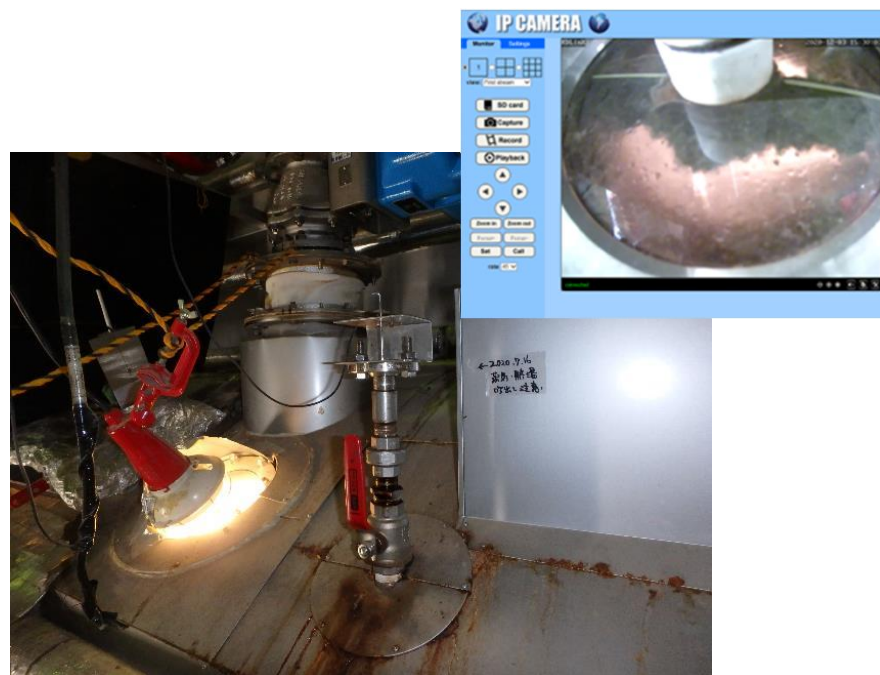
フロート式レベル計および機内カメラ
