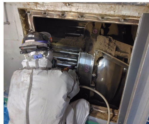
(上右)2022年11月7日 集塵機清掃 (下右)2023年5月1日 乾燥機内点検清掃
