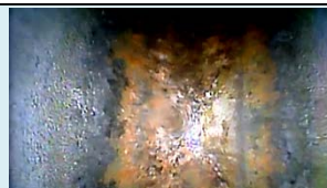
鉄部腐食⇒Aランク
