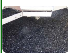
生物膜ろ過施設担体設置状況
