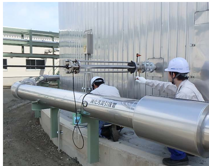
槽内流速測定状況
