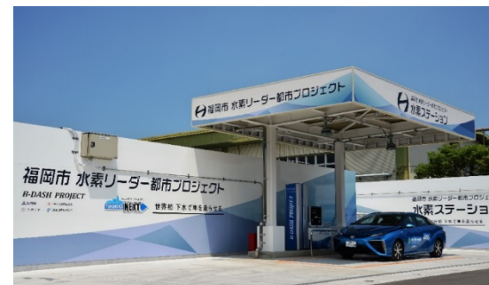
水素ステーション(供給機)
