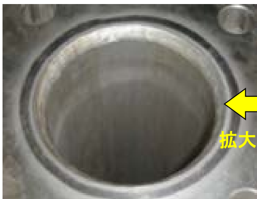
リン除去・回収 運転時使用配管
