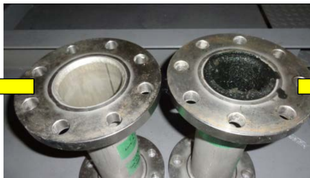
テスト配管 (交換時) [撮影：1月24日]
