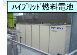
都市ガス併用で消化ガス100%利用可能で発電効率は40%以上
