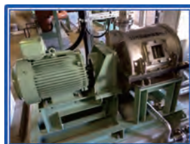
汚泥可溶化設備
