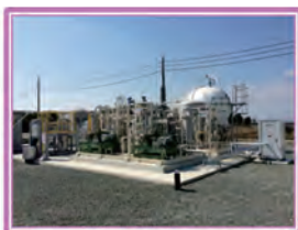
CO 2 分離・回収(CCU)設備
