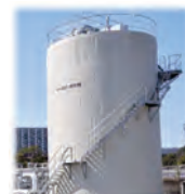
③担体式高温消化槽
