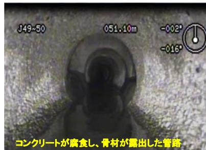
●管路の老朽化に起因する道路陥没
