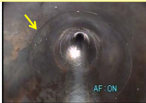
破損をジョイントと見間違いした例
