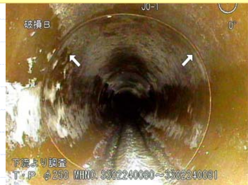
破損をジョイントと見間違いした例
