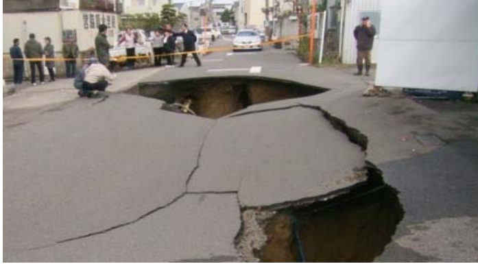
道路陥没事例
