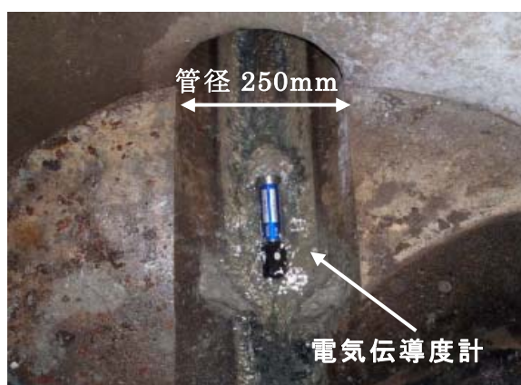
図 1-3 電気伝導度計の設置状況
