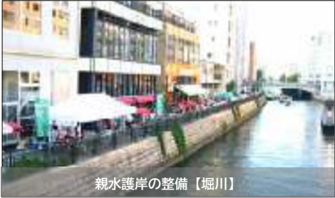
親水護岸の整備【堀川】
