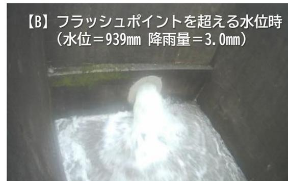
排出量の計測値が概ねH-Q曲線に沿ってプロットされており、ボルテックスバルブの流量調整機能が発揮され、いずれの時点においても設計通りの排出量にコントロールされていることを確認しています。
