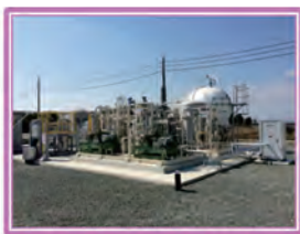
CO 2 分離・回収(CCU)設備
