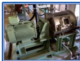
汚泥可溶化設備
