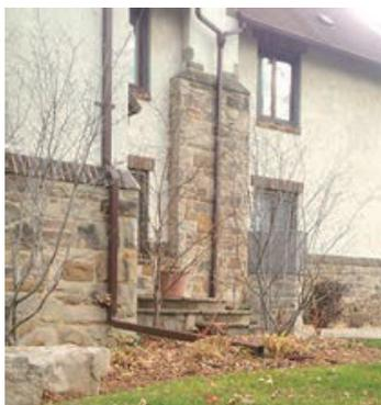
写真-1 屋根排水用縦樋の切断
