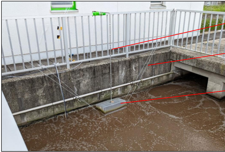
写真 4.4 フロートチャンバー設置の例
