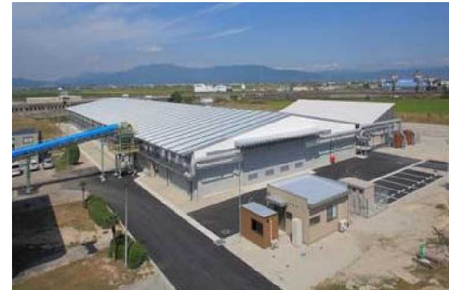
汚泥コンポスト化施設
