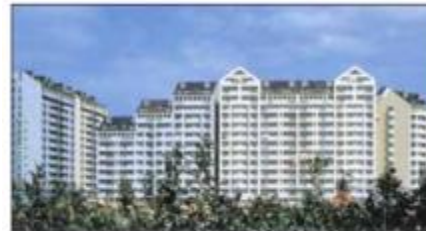
焼却熱を六甲アイランド共同住宅地区へ供給 (神戸市東部スラッジセンター)
