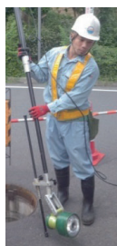
管口カメラ(スクリーニング調査)
