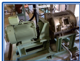
汚泥可溶化設備
