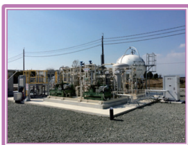
CO 2 分離・回収(CCU)設備
