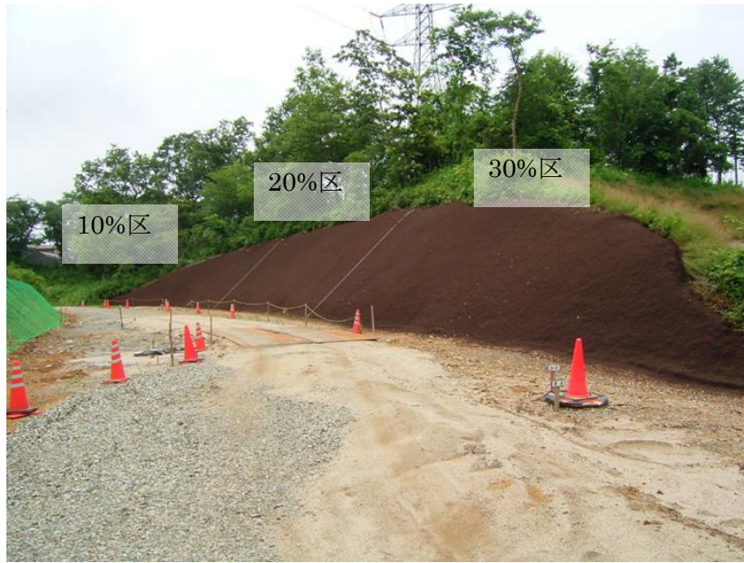
写真-1 表土利用工が行われた法面（施工直後）
