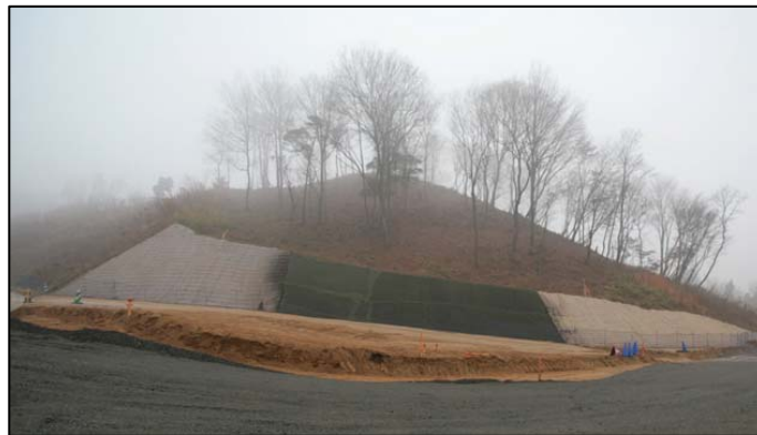
写真-3 国営讃岐まんのう公園の自然侵入促進工の施工直後試験区は、本文で説明した順に左から設置。
