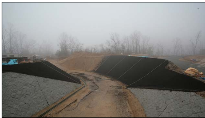
写真-2 国営讃岐まんのう公園の表土利用工の施工直後左側が南向き、右側が北向きの試験区。
