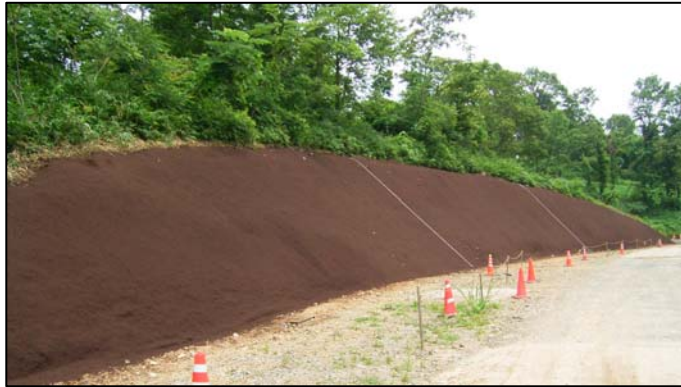
写真-4 国営備北丘陵公園の表土利用工の施工直後
