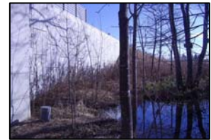
写真-2 擁壁工付近の湿地環境の状況
