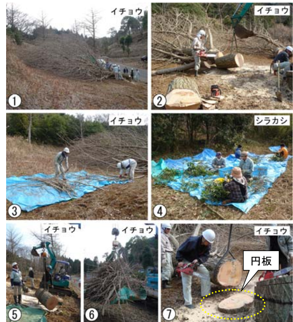
写真1 地上部の伐倒作業
