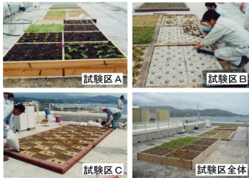
写真 - 1 . 屋上緑化試験区の設置状況
