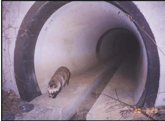
写真1 北関東自動車道の動物横断兼用用水路車道、東水戸道路がある(表2.4)。これらの高速道路における横断構造物について踏査した結果は表2.5のとおりである。表中のアンダーパスはボックスカルバートと排水用管路をまとめたものである。また、横断可能な構造物の分類は、タヌキとイタチがそれぞれ通ることができるかどうか(おおよそ直径がタヌキで6 cm 程度以上、イタチで4 cm 程度以上)で判断し、タヌキとイタチ両方が横断可能な構造物をAタイプ、イタチのみが横断可能な構造物をBタイプとした。
