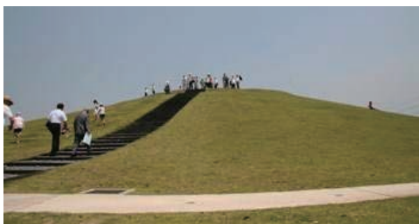
写真-1 津波避難のための築山（ふれあいの丘）
