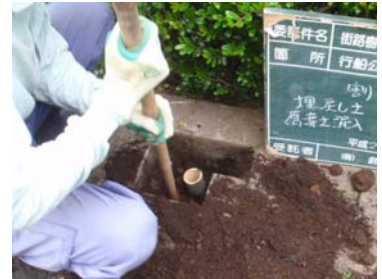
写真-6 土壌改良(割り竹工法)
