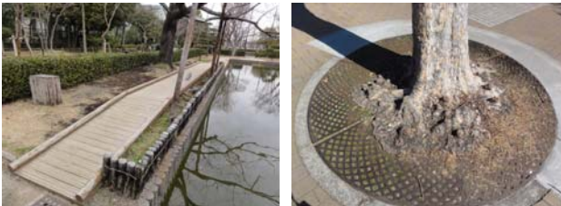
写真-14 踏圧防止板設置状況
