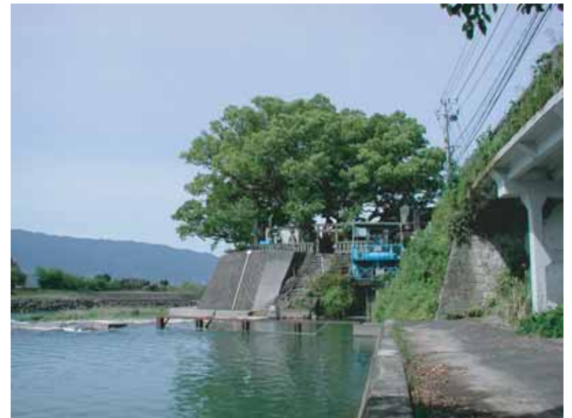
■堀川用水の取水口(出典17-8)
