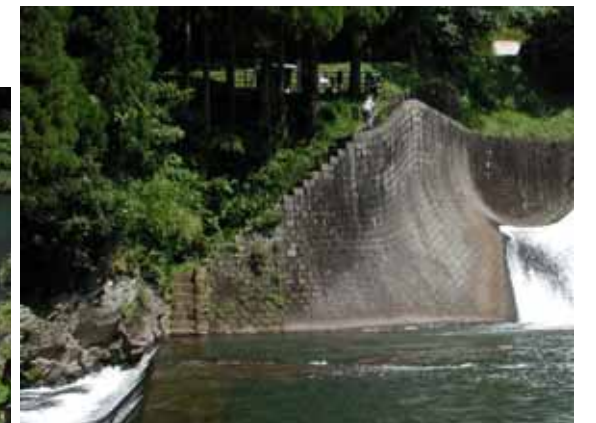
右岸階段部のデザイン(詳細)(出典25-17) 側壁が一定の高さを保っている区間では、階段面が側壁から突出しないようになっているのに対し(上左)、側壁自体が段状に低くなる下流側区間では、階段面が段状の側壁と一致している(上右)。
