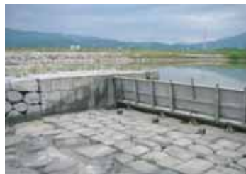
■起伏ゲートの機械室(出典16-20)
