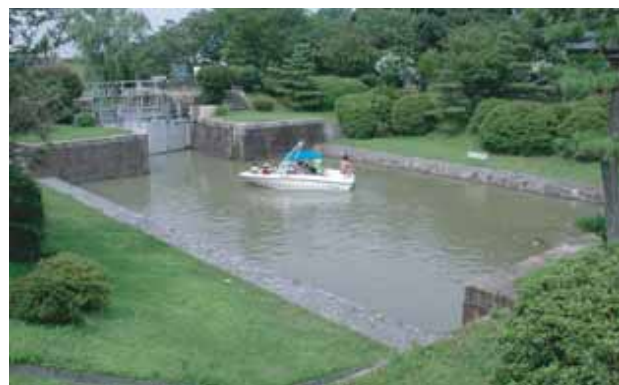
■閘室(手前)と閘柱(側壁)との取り付け部分(出典13-15)
