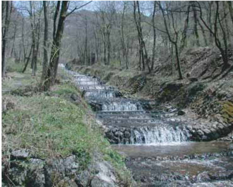
■階段工の全景(出典19-1)
