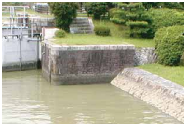
■閘室(手前)と閘柱(側壁)との取り付け部分(出典13-15)
