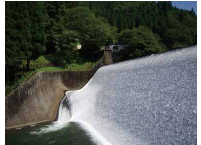
右岸階段部のデザイン(出典25-16) 曲線状の右岸側壁に沿って曲線状の階段が組み込まれている。
