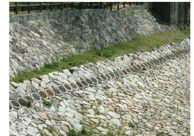
貯水池の護岸(出典23-16) 護岸の一部に石臼がはめ込まれている。
