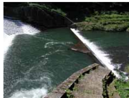
右岸階段部のデザイン(詳細)(出典25-17) 側壁が一定の高さを保っている区間では、階段面が側壁から突出しないようになっているのに対し(上左)、側壁自体が段状に低くなる下流側区間では、階段面が段状の側壁と一致している(上右)。
