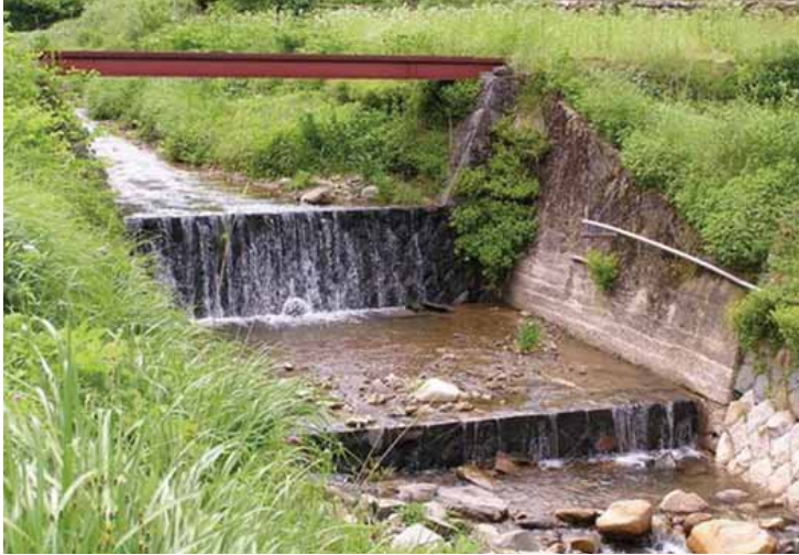
三岳川黒石タイプ(出典21-11) ここに追加された構造物は三岳川白石タイプとは違って、構造物全体を石で覆った、がっしりとしたものになっている。これは、当初のタイプの改良バージョンである。
