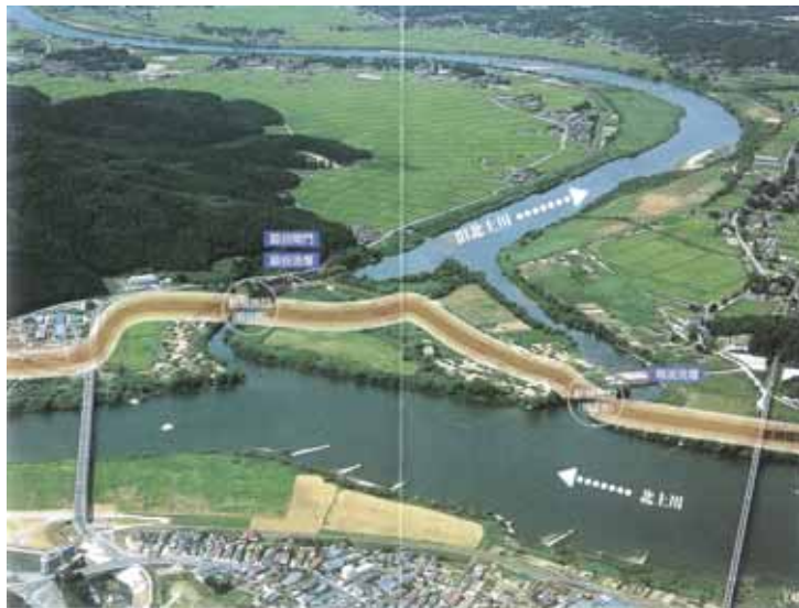
旧北上川分流部の全景(出典15-1)
