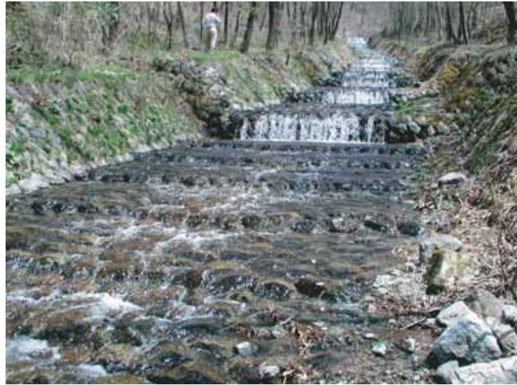
■床固の間には10cm程度の小段が2~3段程度(最下流分は8段)あり、水の流れにリズム感を与えている。(出典19-14)
