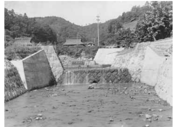
床固工竣工時写真（三岳川：昭和10年頃）（出典21-6）
