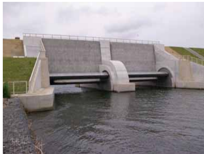
鴉波水門上流側(出典15-12)
