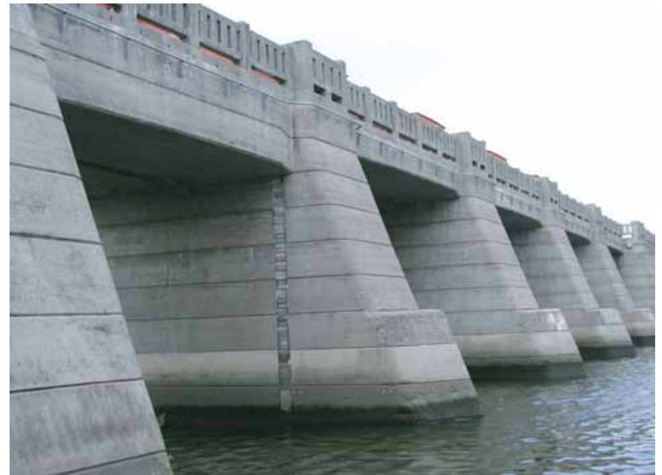
■コンクリートでできた堰柱 (出典14-15)
