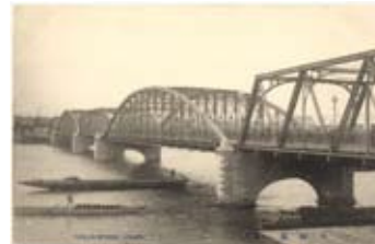
スパン 66 m のボーストリングトラスを主径間に用いた明治 21 年竣工の天神橋
