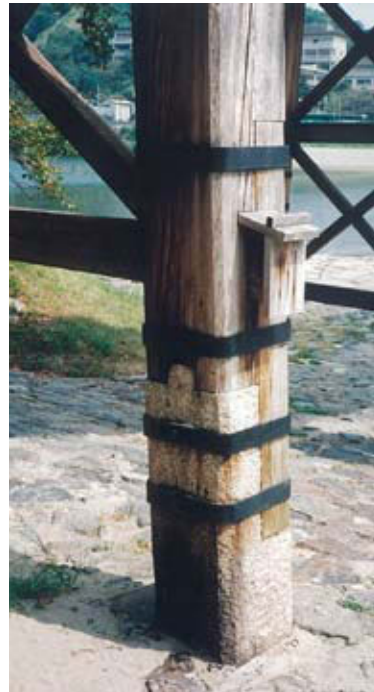
木橋に水は大敵である。地面との接点は石、部材端部は鼻板で覆われている
