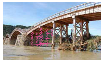
平成17年9月の台風で橋脚2基が流されるも落橋せず。橋脚は回収・再利用された。
