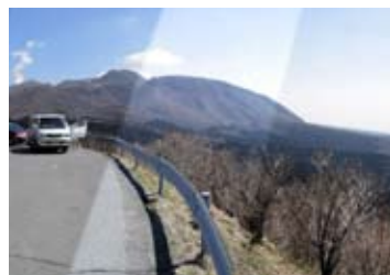
瀬の本（亜鉛メッキのガードレール）
