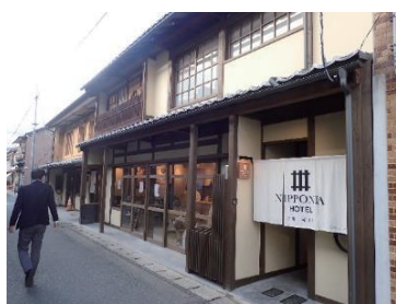
古民家再生店舗。二階は宿泊施設
