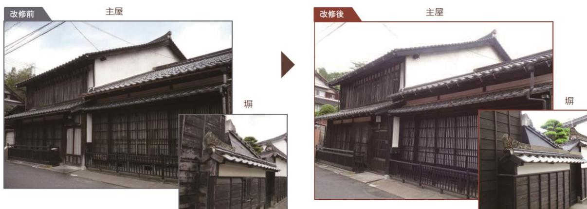
【工事内容】主屋：漆喰塗替え、木製格子補修等／塀：漆喰塗替え、掛戸取替、来待石製棟石直し等
