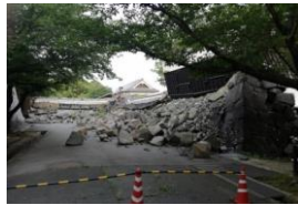
▲熊本城の被災状況
