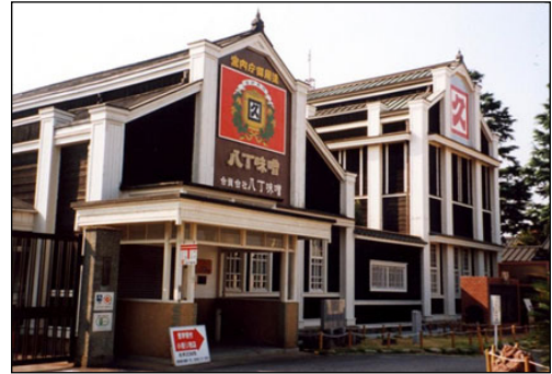
図2-17 カクキュー本社事務所
