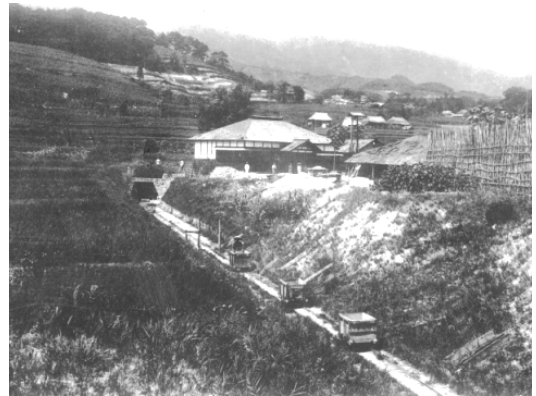
■半田銀山の本坑坑口
