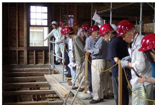
■旧伊達郡役所修理事業現場見学会
