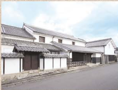
【中島家住宅保存活用計画策定事業 中島家住宅保存整備事業 中島家住宅活用整備事業】
