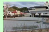
小公園(整備後)
