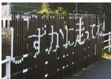
図-2 蛍光テープを巻いたポールの設置例
