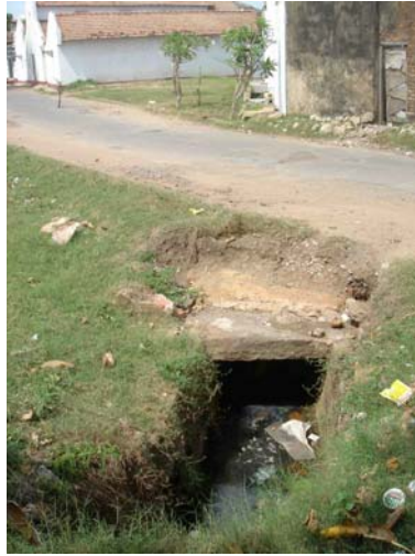
写真-6.5 フォート内北側の YMCA 付近にある排水口の状況
