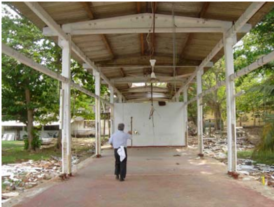
写真-6.6 副港長事務所の状況
