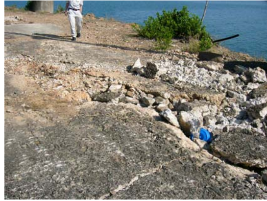
写真-4.17 主防波堤の舗装状況 調査団による調査時点（3/8）
