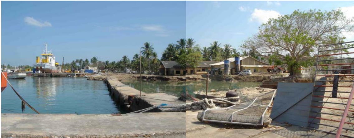
写真-4.11 護岸付近の様子（左：護岸前面側，右：背後側）
