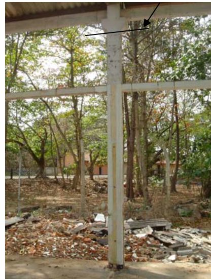
写真-6.7 副港長事務所の浸水痕跡
