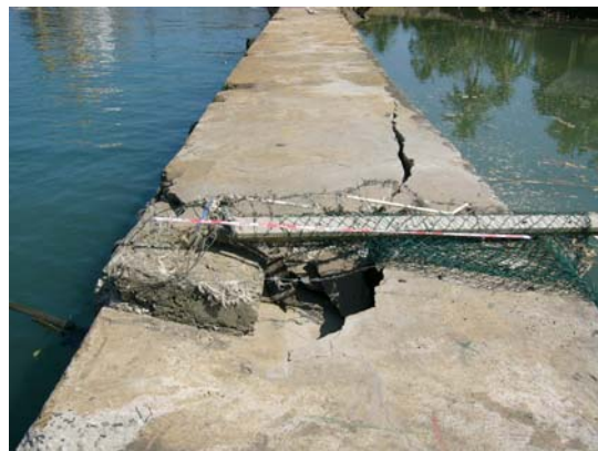
写真-4.10 破損・吸い出しの顕著な箇所 (左：護岸前面側，右：背後側)
