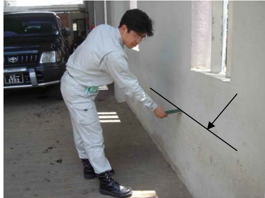
写真-6.8 ゴール地方行政庁舎における浸水痕跡
