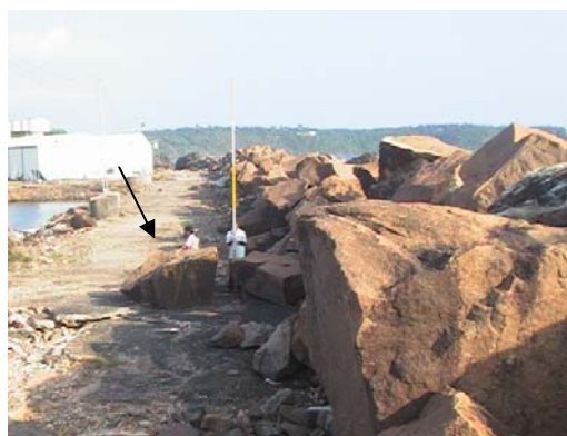
写真 4-15 被災直後の主防波堤の状況と移動した岩石 (矢印) (左：港内側，右：港外側，日本港湾コンサルタント提供)
