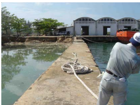
写真-4.9 背後が吸い出された護岸 (左：背後側，右：護岸前面側)
