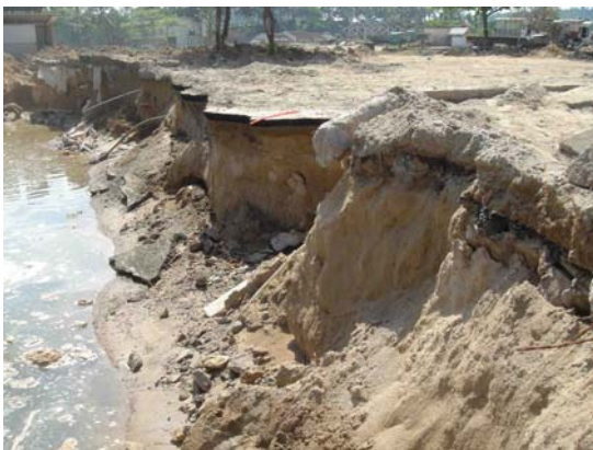
写真-4.12 護岸背後の状況
