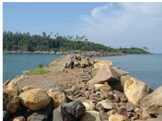
写真-7.2 Mirissa 漁港防波堤の状況
