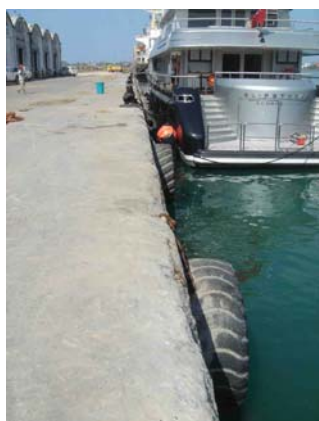
写真-4.3 Closenburg ふ頭の老朽化状況
