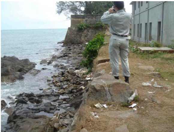
写真-6.4 フォート北東部の状況（周囲と比較して護岸高さが低い）
