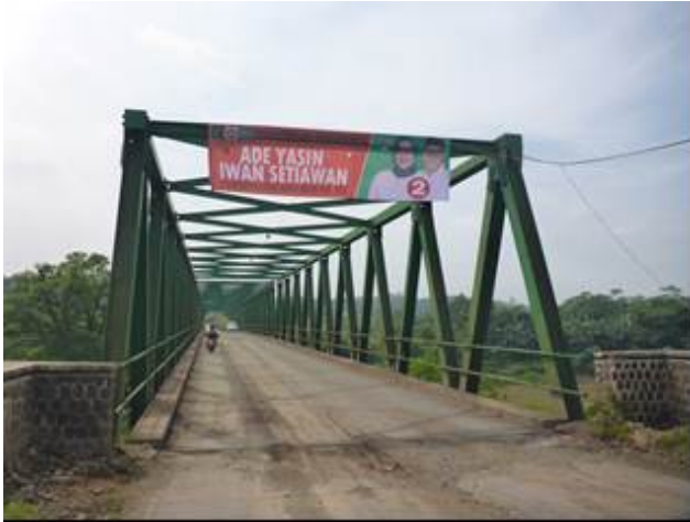
試験施工場所である Cisadane Bridge
