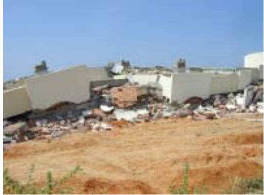
写真 4 完全に崩壊した建物
