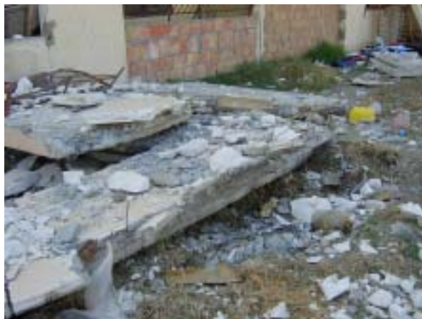
写真 2 2 落下した PC パネル
