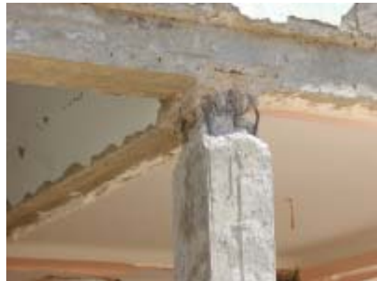
写真 6 柱端部の破壊
