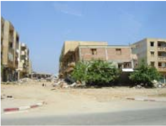
写真 3 完全に崩壊した建物
