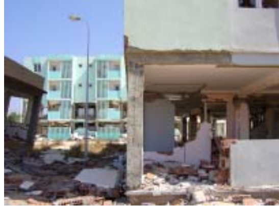
写真8 柱端部の破壊
