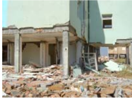
写真 2 1 階の煉瓦壁の崩落
