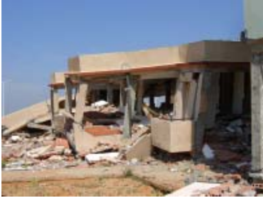
写真7 大破した建物
