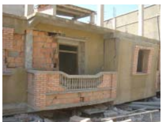
写真12 ピロティ階の崩壊
