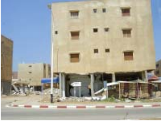
写真 1 1 階の煉瓦壁の崩落
