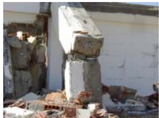
写真10 柱の破壊（主筋の破断）
