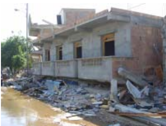
写真11 ピロティ階の崩壊
