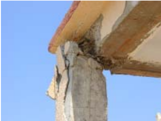
写真9 接合部の破壊
