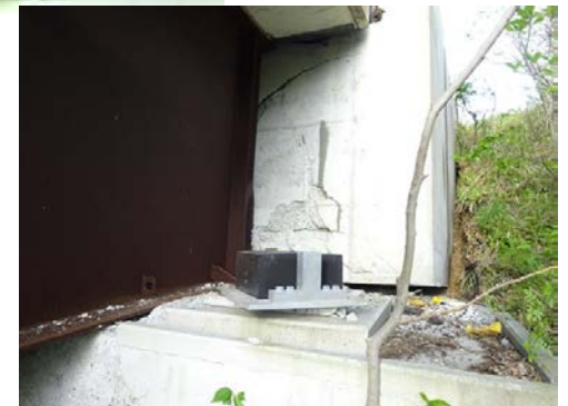
橋桁を支える 支点の損傷
