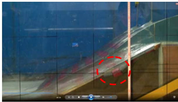
写真-5 吸い出しによって局所的に沈下した裏法被覆工（フィルター層無し）
