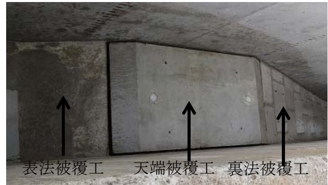
写真-9 法肩ブロックを天端被覆工と一体化したケース（高落差実験水路）
