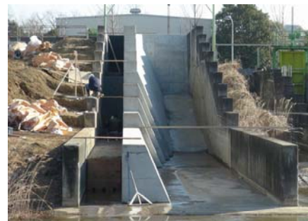
写真-2 高落差実験水路(縮尺 1/2)
