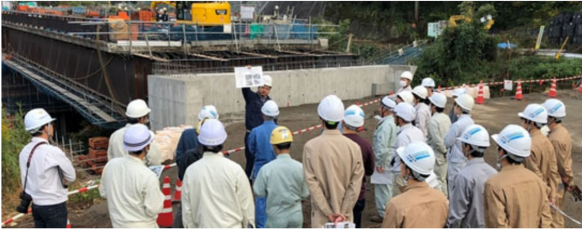
建設技術者を対象とした復旧状況の説明(俵山大橋)
