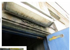
爆裂による鉄筋の露出 [波浪実験水路]
