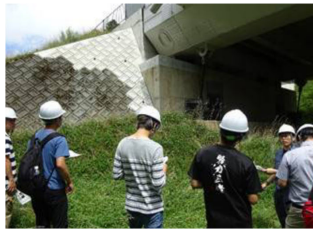
土木工学を専攻する学生を対象とした 復旧状況の説明(桑鶴大橋)
