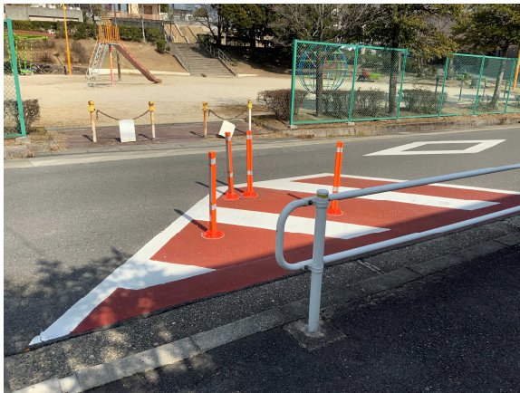
ゴム製ポールの配置
