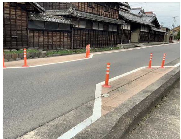
ゴム製ポールの一部撤去
