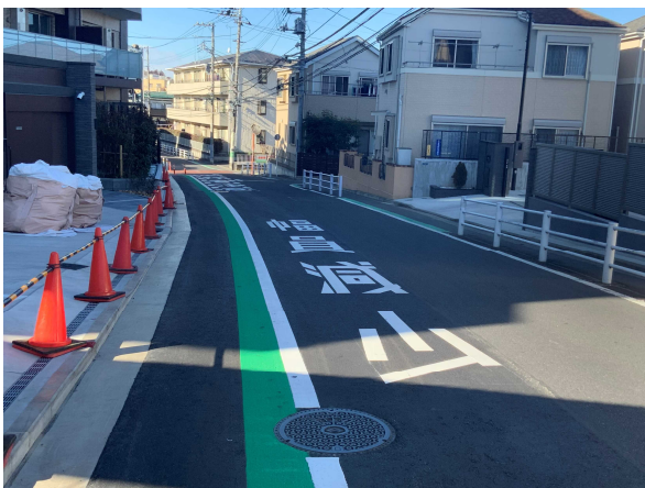
張り出し設置側手前の路面表示
