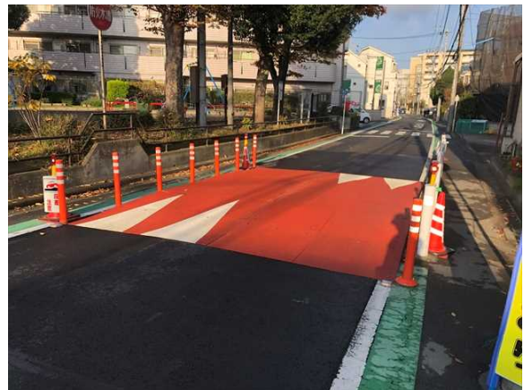
ゴム製ポールの設置
