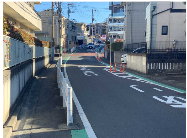
非張り出し設置側からの進入視点
