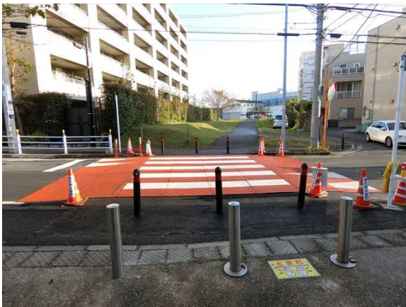
歩道へのすりつけ
